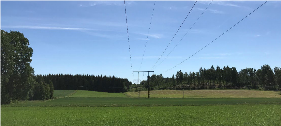
Figur 49. Vattenfall Eldistributions 22 kV-ledning som går genom projektområdet. Foto av Cajsa Abrahamsson.
