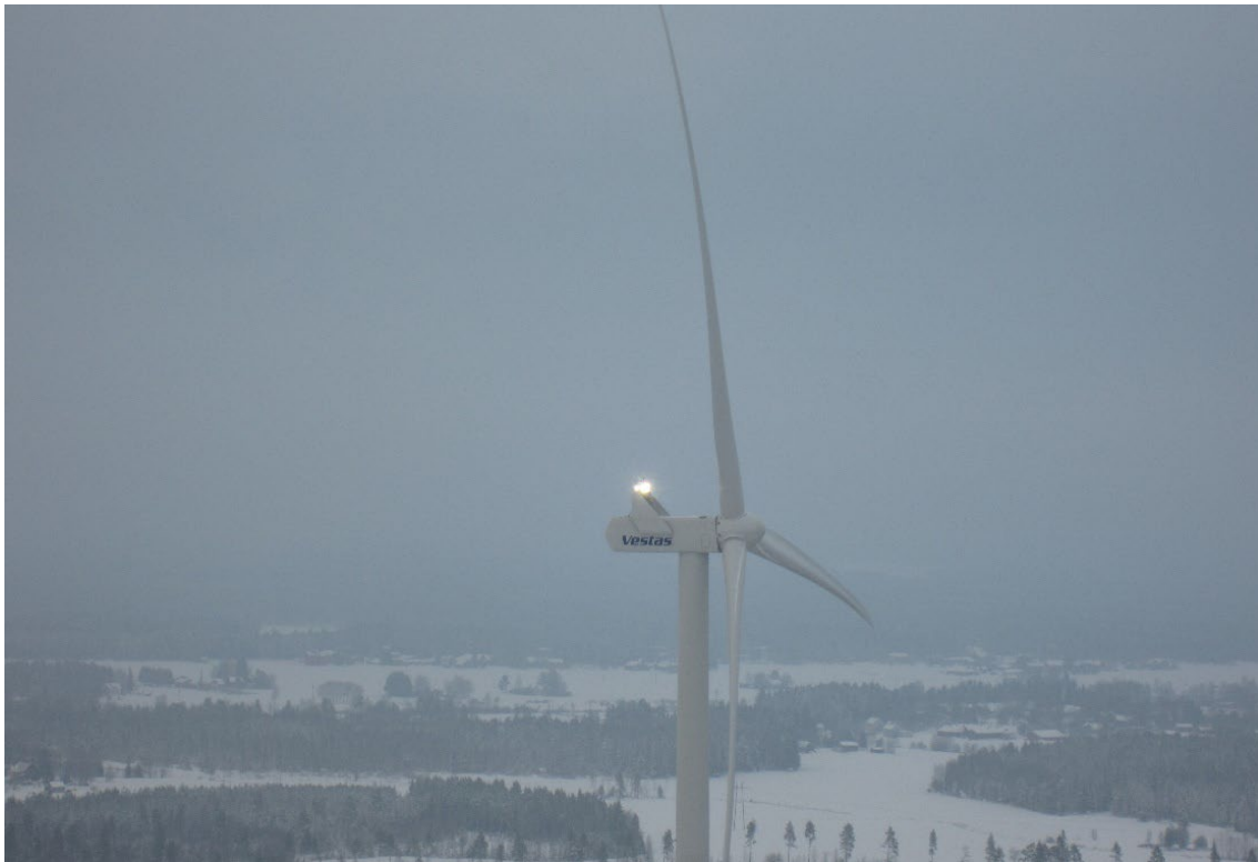
Figur 25. Hinderljus på ett Vestas V126 i vindkraftspark i närheten av Vähäkylä i Finland. Foto av Cajsa Abrahamsson.
