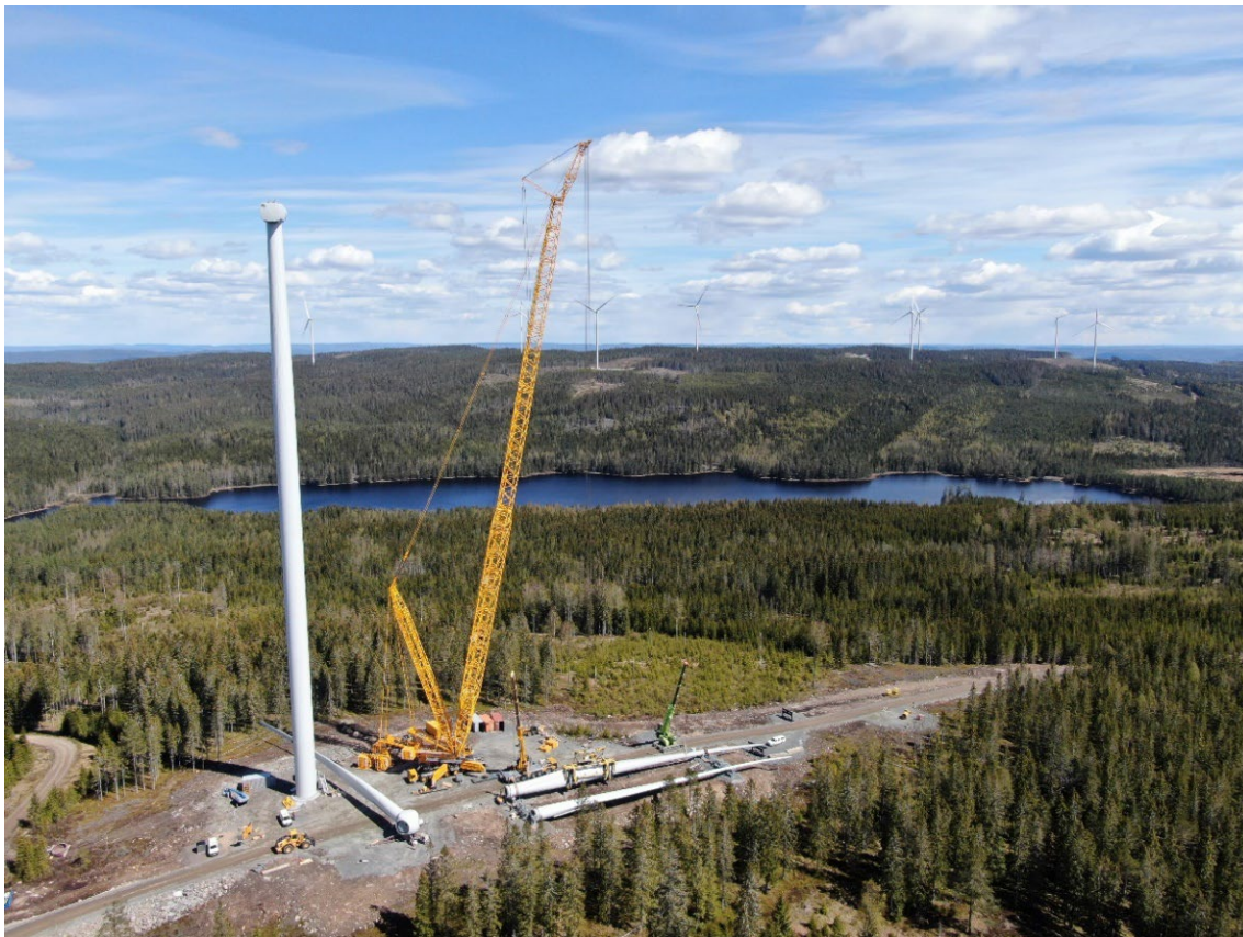
Figur 16. Byggnation av ett vindkraftverk i vindkraftsparken Norra Länsmansberget. Montering av rotorblad är på gång. Foto av Jonathan Hjorth.
