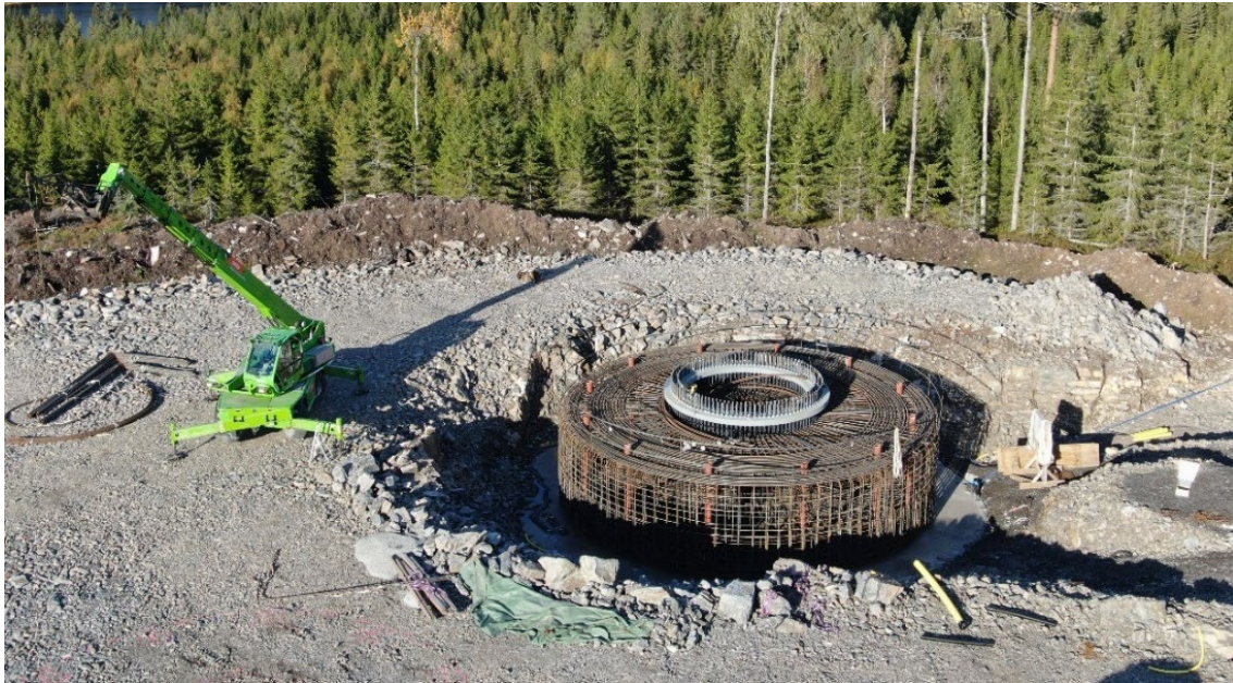
Figur 11. Ett bergsförankrat fundament under byggnation av vindkraftspark Norra Länsmansberget i Sunne kommun. I nästa skede ska fundamentet fyllas med cement. Foto av Jonathan Hjorth.
